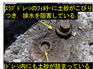
写真-10 開削箇所 e
