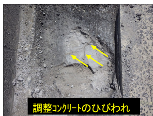
写真-7 開削箇所 c-1
