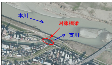
図-1 対象橋梁周辺状況 1)
