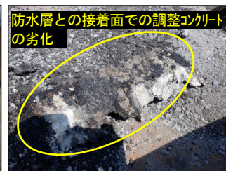
写真-6 開削箇所 b
