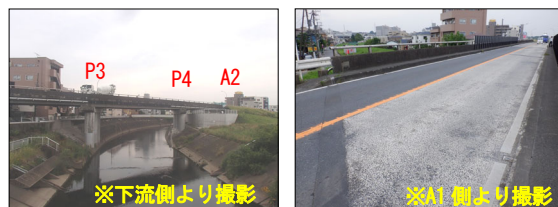
写真-1 橋梁側面状況
