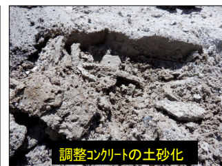
写真-8 開削箇所 c-2
