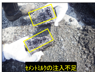
写真-9 開削箇所 d
