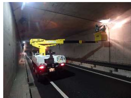
図-7 作業状況(高所作業車)
