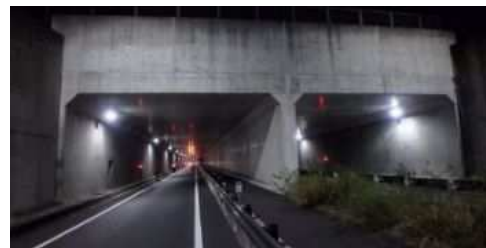
図-2 大型カルバート全景
