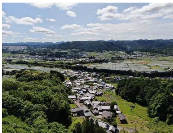
写真-1 谷出口下流の状況
