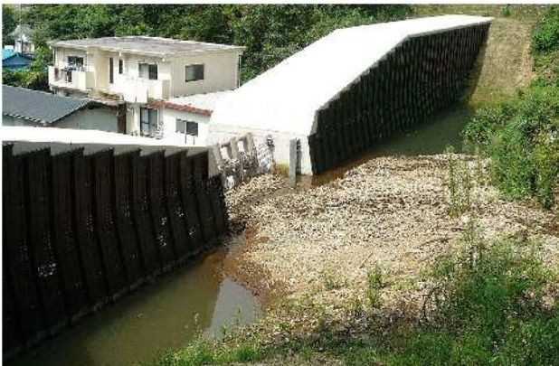
写真-3 土石流捕捉実績 7)
