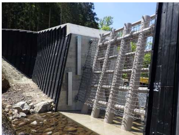
写真-2 ワイヤロープ設置状況 7)
