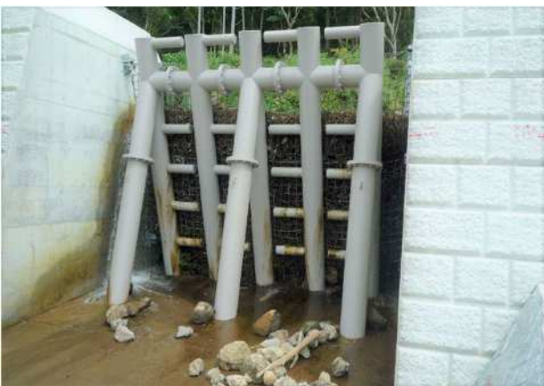
写真-4 土石流捕捉実績 7)
