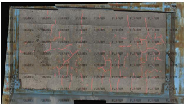
図-3 ひびみっけで取得したひびわれ
