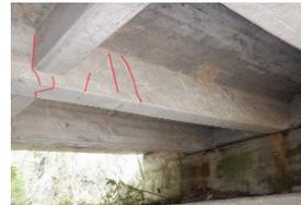
図-3 主桁の曲げひびわれ
