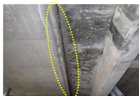
図-4 床版の漏水・滞水
