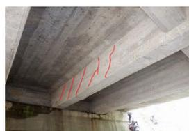
図-2 主桁のせん断ひびわれ
