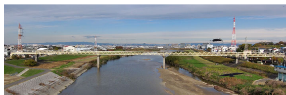
写真-2 点検対象橋梁 全景写真
