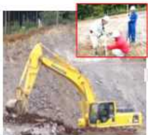
丁張りを目印に施工
