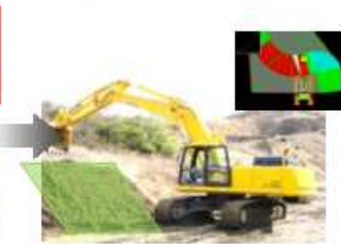
3次元設計データに沿って施工
