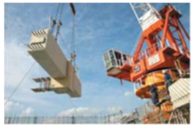
定型部材を組み合わせた施工
