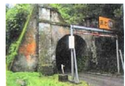
山中トンネル
